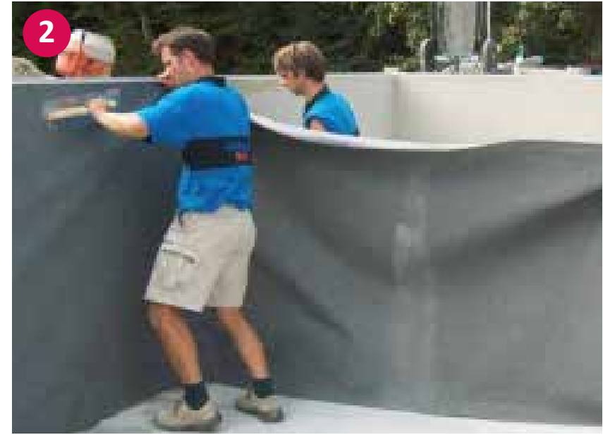
▲ Punktuelle Befestigung der Vliestrennlage mittels Styroporkleber
