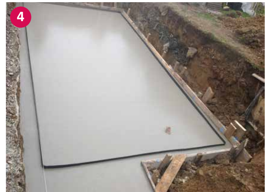
▲ Die Bodenplatte kann mit einem Fugenband für zusätzliche Abdichtung ausgestattet werden.
