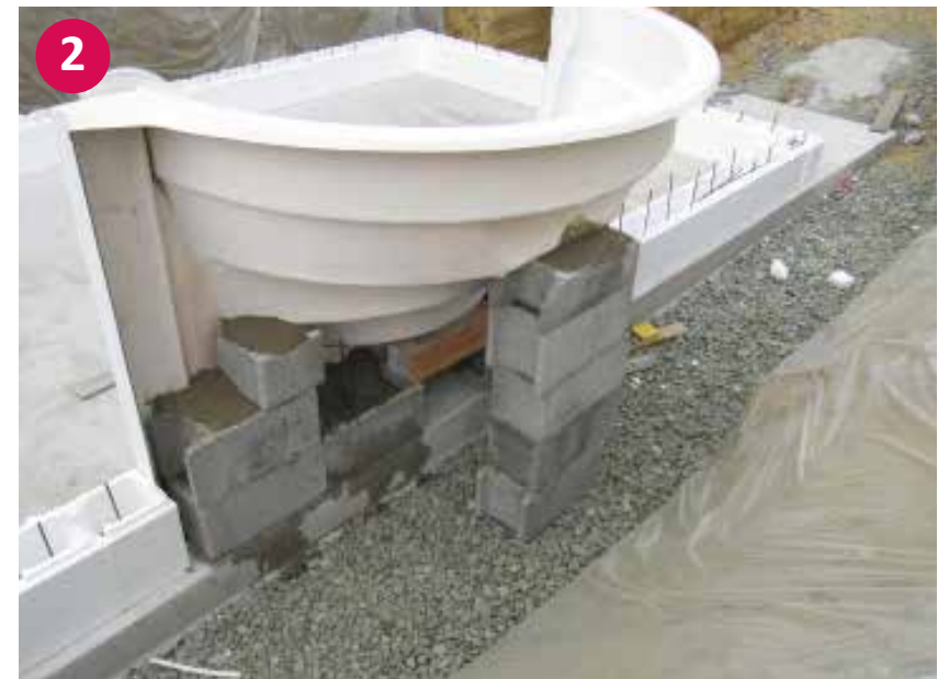
▲ Untermauerung der Römertreppe
