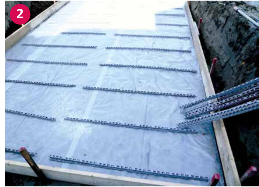
▲ Abschallung der Bodenplatte
