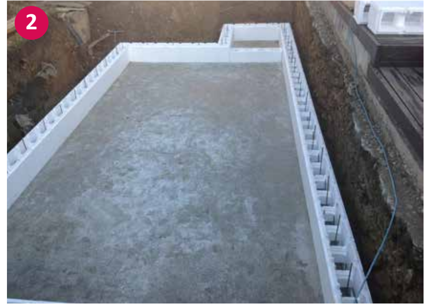
▲ Ansätzen der ersten Reihe Styropor Steine
