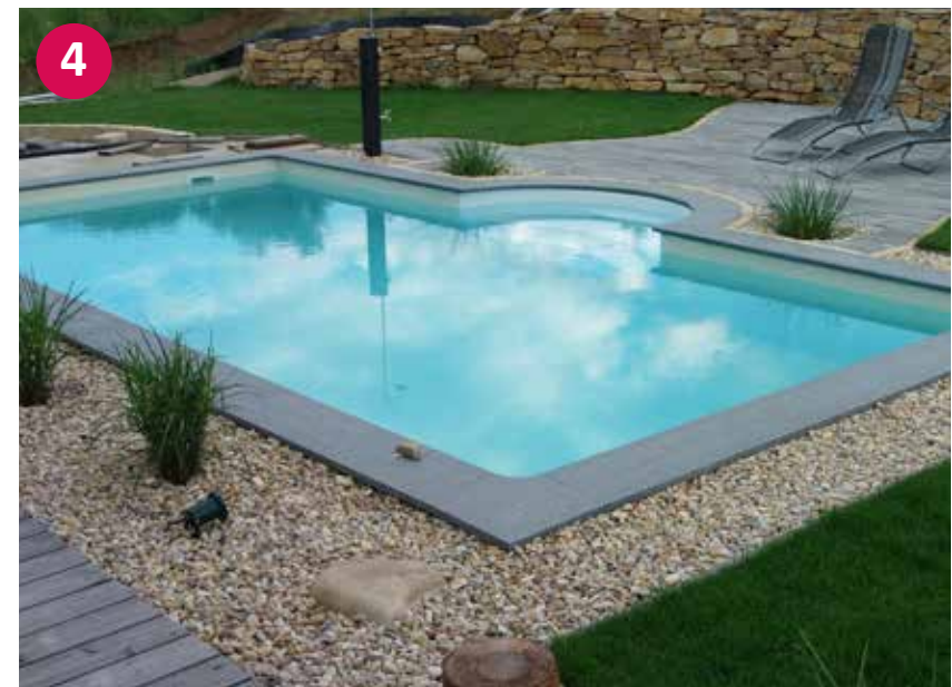
▲ Fertiges Styroporsteinbecken mit Römertreppe
